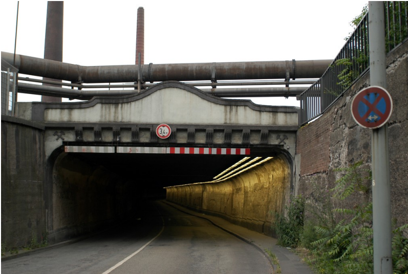
Tunnel Matenastraße, Duisburg-Bruckhausen (2005) Fotograf/Urheber: Gelhar, Martina
