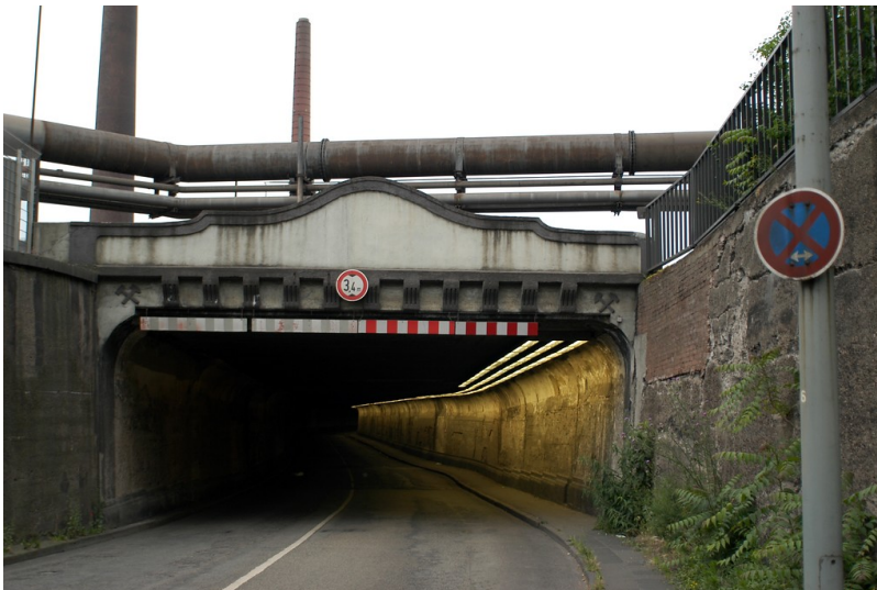
Tunnel Matenastraße, Duisburg-Bruckhausen (2005) Fotograf/Urheber: Gelhar, Martina
