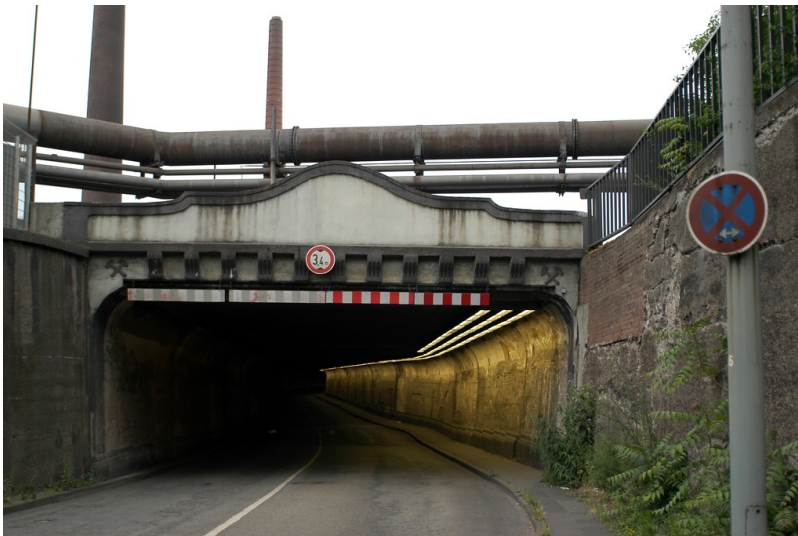
Tunnel Matenastraße, Duisburg-Bruckhausen (2005) Fotograf/Urheber: Gelhar, Martina
