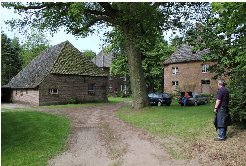
Gebäudegruppe Pastorat, Schule und Forsthaus der ehemaligen Oberförsterei von Diersfordt (2012) Fotograf/Urheber: Burggraaff, Peter
