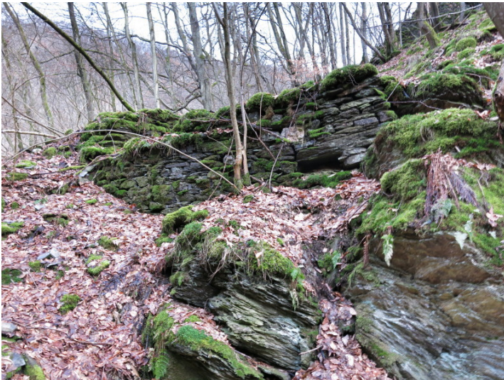
Mauerreste der Lumpenmühle bei Dornholzhausen (2013). Fotograf/Urheber: Dehe, Silke
