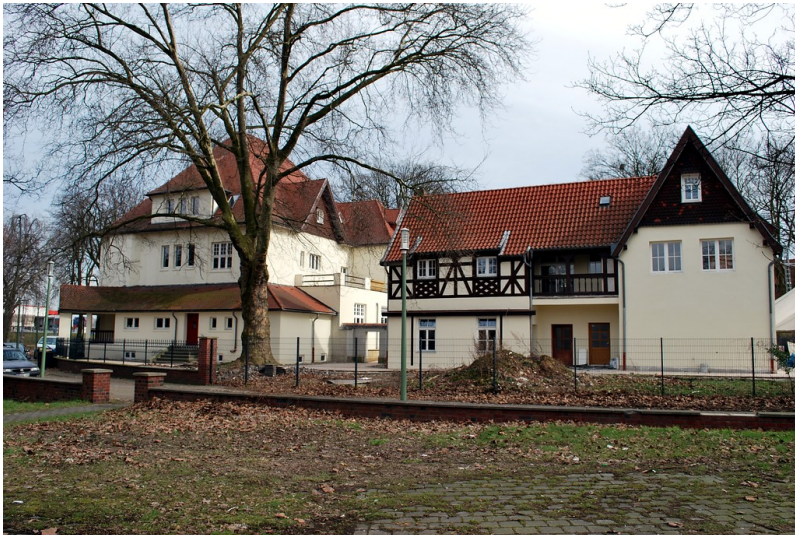
Direktorenvilla mit Kutscherhaus in der Siedlung Bliersheim, Duisburg-Rheinhausen (2013) Fotograf/Urheber: Gelhar, Martina
