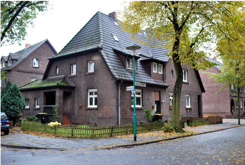
Wohnhaus in der Siedlung Zeche Wehofen in Duisburg (2012) Fotograf/Urheber: Gelhar, Martina
