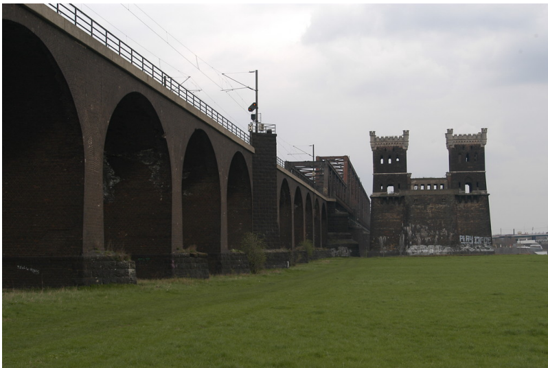
Rheinbrücke Rheinhausen/Hochfeld (2006) Fotograf/Urheber: Gelhar, Martina
