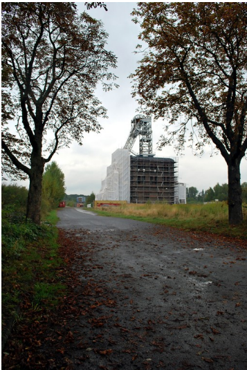
Fördergerüst und Schachthalle der Zeche Sterkrade I in Oberhausen (2012) Fotograf/Urheber: Gelhar, Martina
