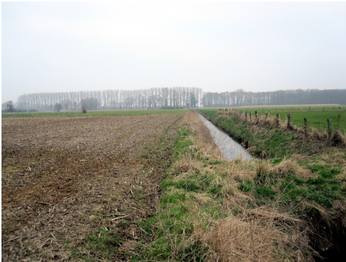
Entwässerungsgraben "Mittelley" im Uedemerbruch (2011) Fotograf/Urheber: Burggraaff, Peter
