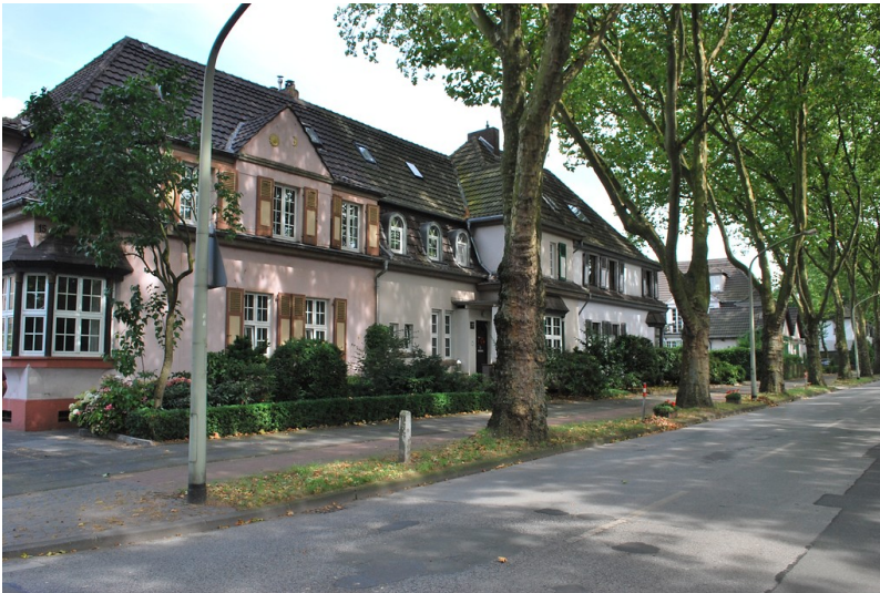
Villen der Beamensiedlung Hüttenheim II in der Schulz-Knaudt-Straße in Duisburg (2012) Fotograf/Urheber: Gelhar, Martina
