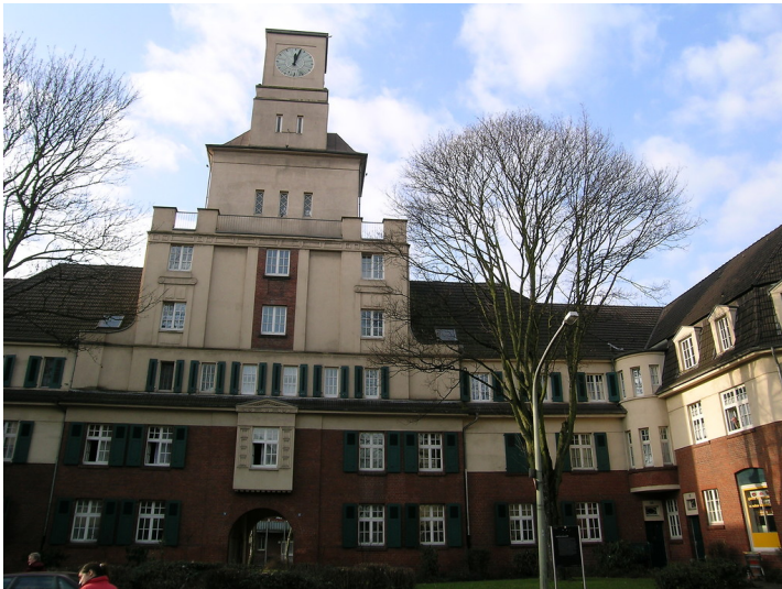
Uhrenturm als Zentrum der Siedlung Hüttenheim I in Duisburg (2005) Fotograf/Urheber: Gelhar, Martina
