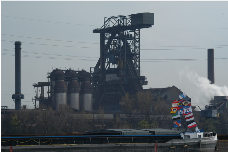
Hochofen der Hüttenwerke Krupp-Mannesmann in Duisburg-Huckingen (2006) Fotograf/Urheber: Gelhar, Martina
