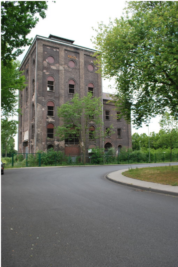
Der denkmalgeschützte Malakoffturm über Schacht I der Zeche Rheinpreußen ist mit einem Teil der Schachthalle erhalten geblieben. Die Giebelinschrift verweist auf das Jahr 1879, als die Förderung begann (2015). Fotograf/Urheber: Martina Gelhar
