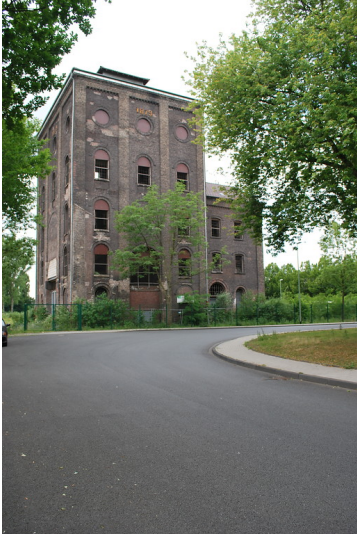
Der denkmalgeschützte Malakoffturm über Schacht I der Zeche Rheinpreußen ist mit einem Teil der Schachthalle erhalten geblieben. Die Giebelinschrift verweist auf das Jahr 1879, als die Förderung begann (2015). Fotograf/Urheber: Martina Gelhar
