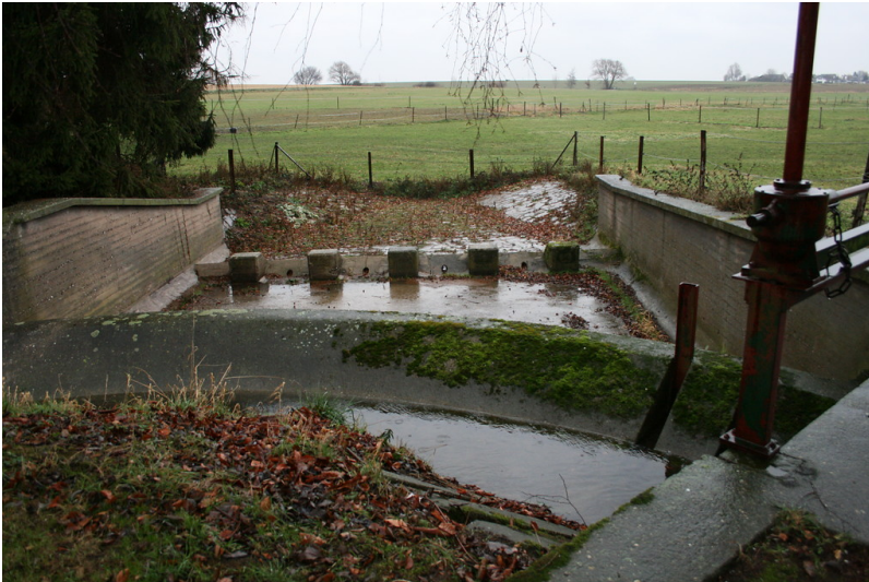
Heute befindet sich an der Sintherner Ölmühle der Einlauf in den Retentionsraum des Hochwasserrückhaltebeckens Sinthern. Fotograf/Urheber: Dr. Ralf Kreiner
