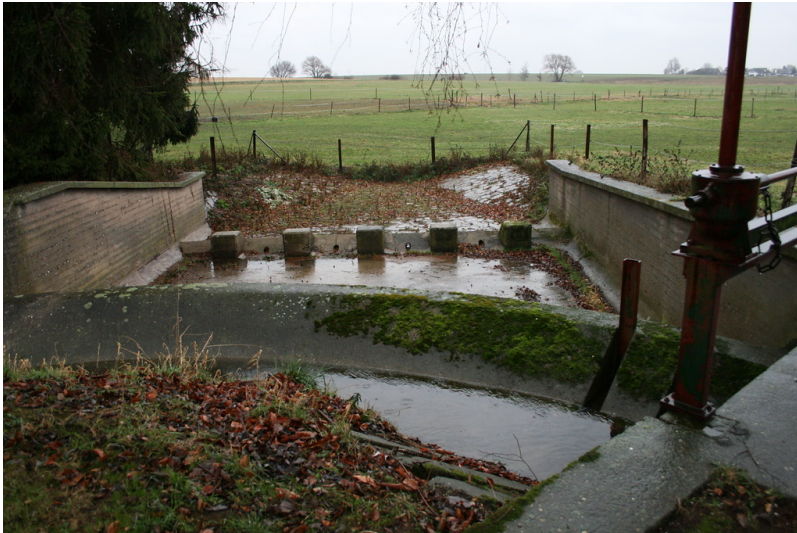
Heute befindet sich an der Sintherner Ölmühle der Einlauf in den Retentionsraum des Hochwasserrückhaltebeckens Sinthern. Fotograf/Urheber: Dr. Ralf Kreiner
