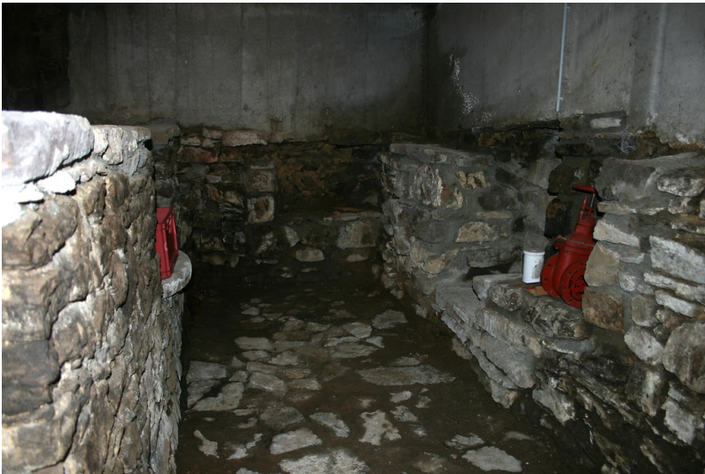
Der ehemalige Getriebekeller in der Mühle. Hier drehte sich einst die später gekappte Mühlradwelle. Fotograf/Urheber: Dr. Ralf Kreiner
