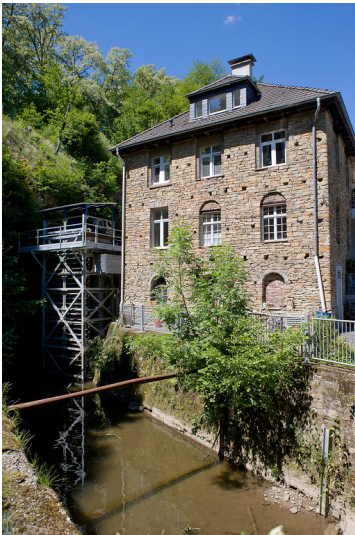
Das alte Werks- und Generatorenhaus mit Untergraben und Wasserkraftanlage (2009) Fotograf/Urheber: Stefan Arendt
