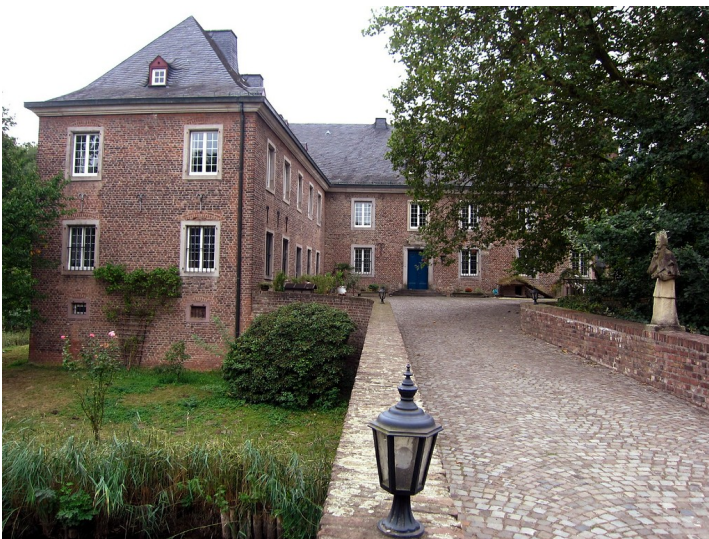
Haupthaus und brückenartiger Übergang über die umgebende Gräfte von Schloß Bachem (2013) Fotograf/Urheber: Knöchel, Franz-Josef
