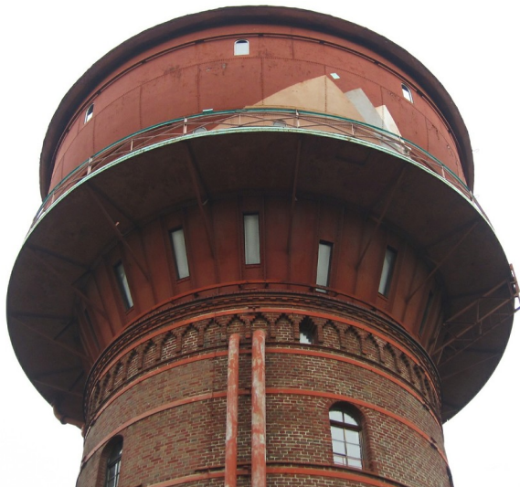
Wasserbehälter im oberen Teil des Frechener Wasserturms (2013). Fotograf/Urheber: Knöchel, Franz-Josef
