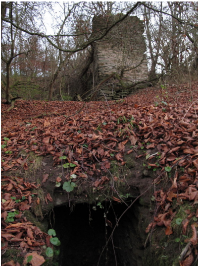
Die Ruine der Beerbachmühle bzw. Beerenbachmühle / Bärbacher Mühle (2012). Fotograf/Urheber: Dehe, Silke
