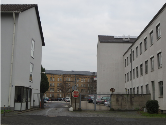
Alte und neue Gebäude der Ermekeilkaserne gesehen von der Reuterstraße (2012) Fotograf/Urheber: Bükers, Katharina
