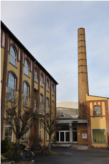
Schornstein und Gebäudeteil der ehemaligen Tapetenfabrik Beuel Fotograf/Urheber: Alt, Caroline
