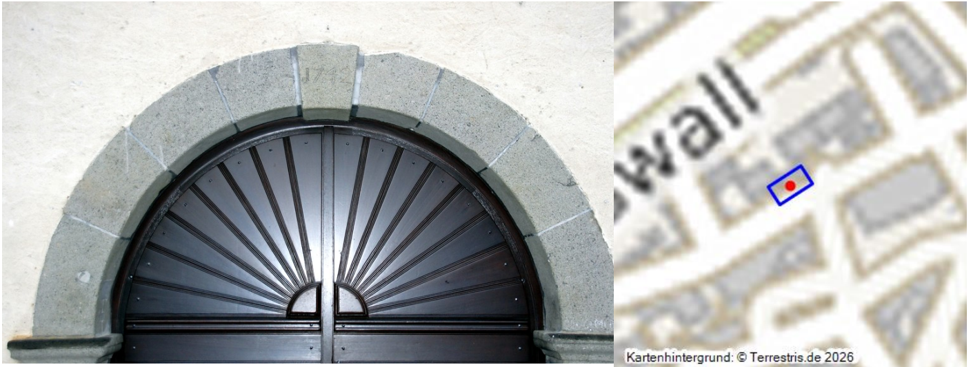
Torbogen der Zehntscheune Ahrweiler (2016) Fotograf/Urheber: Simone Jakobi
