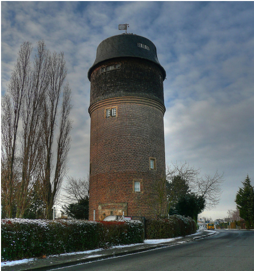
Wasserturm in Merzenich Fotograf/Urheber: Meurer, Karl-Heinz
