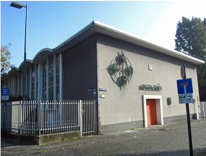
Das Umspannwerk "Unterwerk Mitte" am Großen Griechenmarkt 59 in Köln-Altstadt-Süd (2012). Fotograf/Urheber: Knöchel, Franz-Josef
