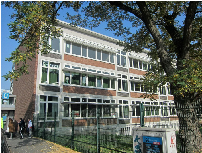
Das Hauptgebäude der Katholischen Hauptschule KHS am Griechenmarkt in Köln (2012). Fotograf/Urheber: Knöchel, Franz-Josef
