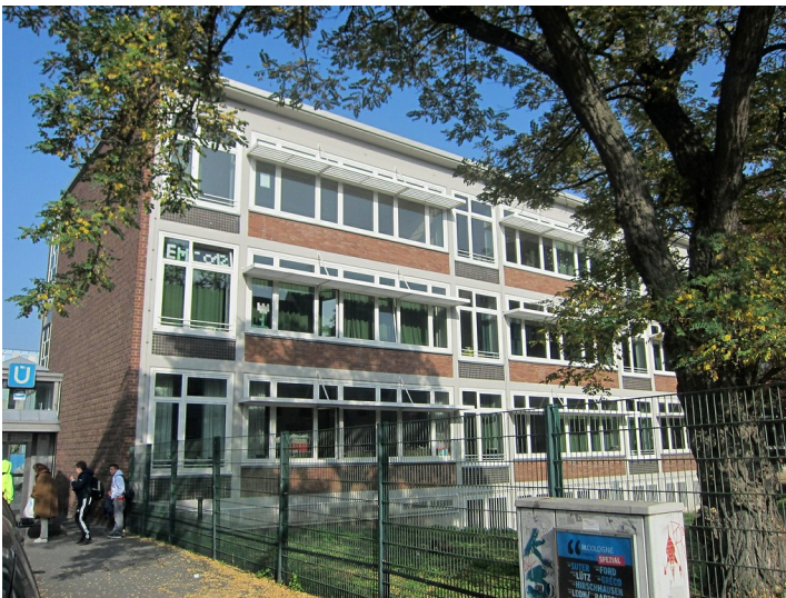
Das Hauptgebäude der Katholischen Hauptschule KHS am Griechenmarkt in Köln (2012). Fotograf/Urheber: Knöchel, Franz-Josef
