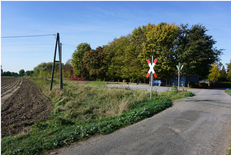
Bahnhof Menzelen-Ost, Blick auf den ehemaligen Bahnsteig, Übergang Borther Weg (2018) Fotograf/Urheber: Claus Weber
