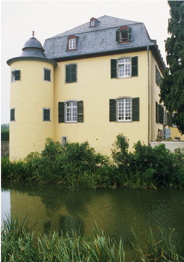
Meckenheim-Lüftelberg, Schloss Fotograf/Urheber: Jürgen Gregori
