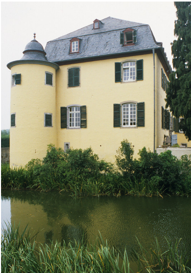
Meckenheim-Lüftelberg, Schloss Fotograf/Urheber: Gregori, Jürgen
