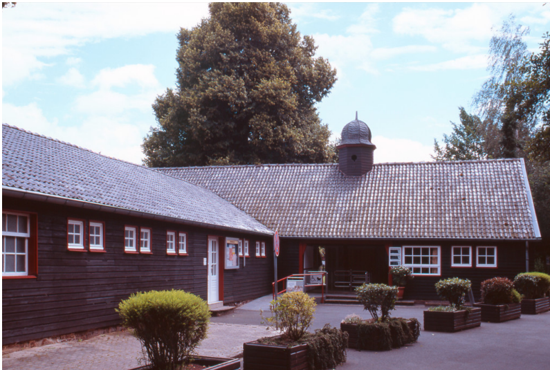
Euskirchen-Kirchheim, Badeanstalt Steinbachtalsperre Fotograf/Urheber: Jürgen Gregori
