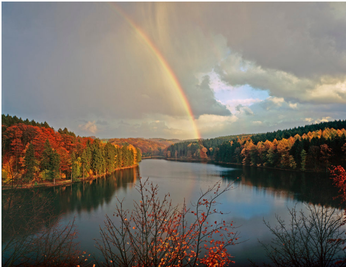
Eschbachtalsperre in Remscheid (2003) Fotograf/Urheber: Holger Klaes
