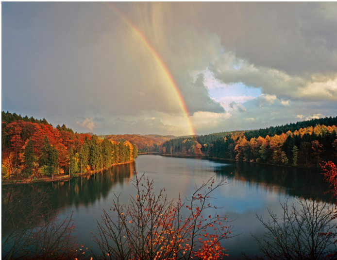
Eschbachtalsperre in Remscheid (2003) Fotograf/Urheber: Holger Klaes
