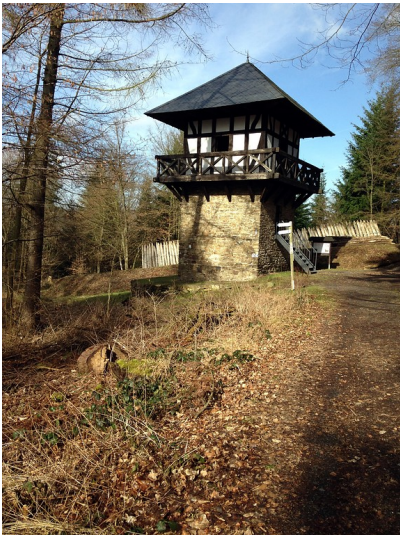
Der rekonstruierte Limesturm WP 1/54 in Sayn aus südlicher Richtung (2015).
