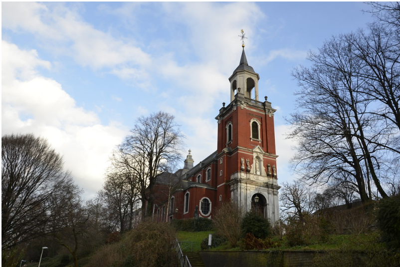
Katholische Pfarrkirche St. Michael in Aachen-Burtscheid (2015) Fotograf/Urheber: Leblebici, Suzan
