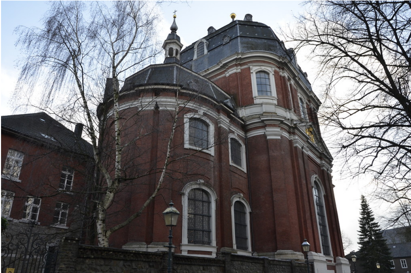
Nordseite der barocken Pfarrkirche St. Johann Baptist in Aachen-Burtscheid (2015) Fotograf/Urheber: Leblebici, Suzan
