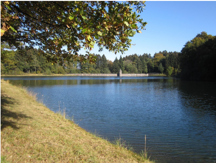
Panzertalsperre Fotograf/Urheber: Boomers, Jan
