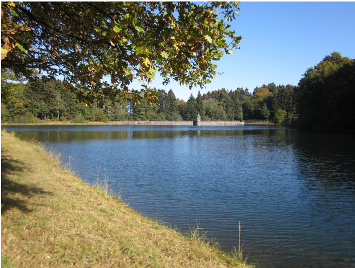
Panzertalsperre Fotograf/Urheber: Boomers, Jan
