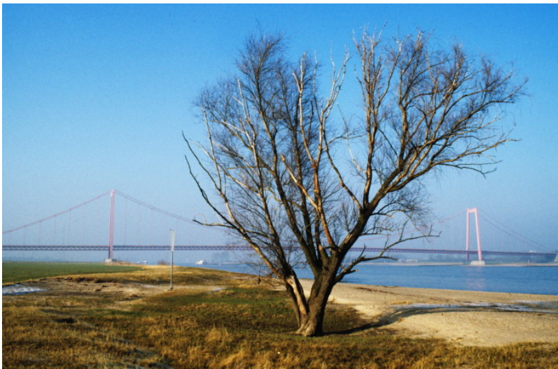
Rheinbrücke bei Emmerich, Kreis Kleve (2007) Fotograf/Urheber: Jürgen Gregori
