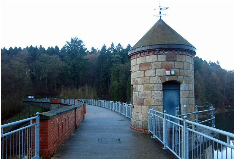
Blick über die Staumauer der Ronsdorfer Talsperre bei Wuppertal (2014). Fotograf/Urheber: Franz-Josef Knöchel
