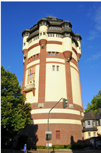
Wasserturm Mönchengladbach Fotograf/Urheber: Flinspach, Karlheinz
