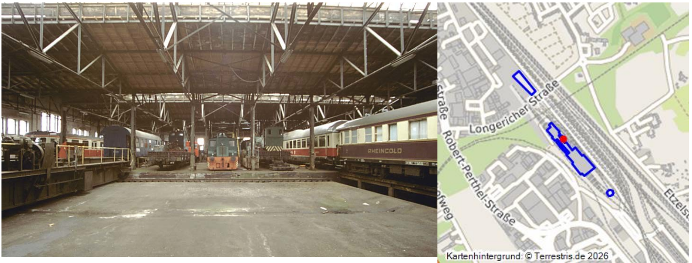
Bahnbetriebswerk Nippes, Halle innen 2 (1997) Fotograf/Urheber: Buschmann, Walter / LVR-ADR
