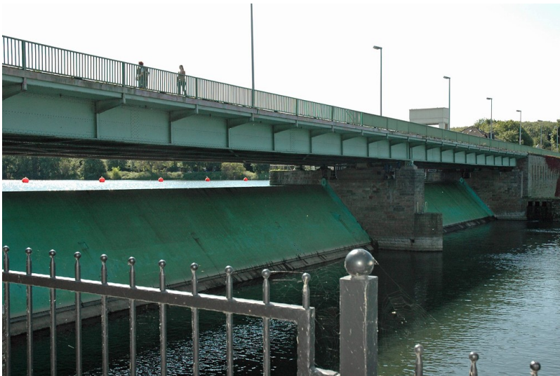
Kraftwerk, Stauwehr und Schleuse in Essen (Kettwig) Fotograf/Urheber: Buchholz, Karl-Heinz
