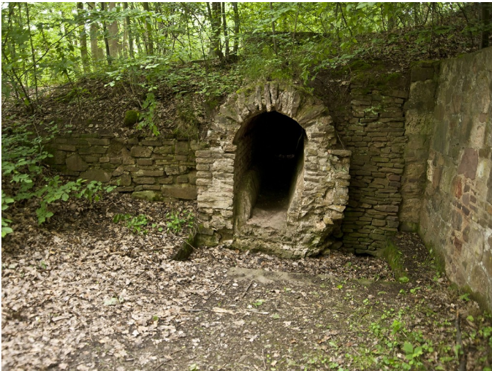
Kanalmeisterei der römischen Wasserleitung in Breitenbenden (2012) Fotograf/Urheber: LVR-Amt für Bodendenkmalpflege
