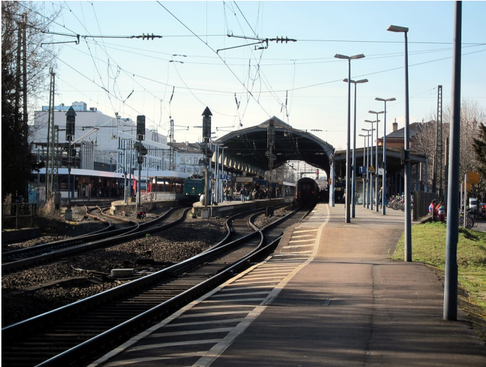
Hauptbahnhof Bonn mit der Bahnsteigüberdachung, vom Bahnsteig an Gleis 1 aus gesehen (2015). Fotograf/Urheber: Knieps, Elmar
