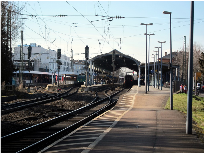
Hauptbahnhof Bonn mit der Bahnsteigüberdachung, vom Bahnsteig an Gleis 1 aus gesehen (2015). Fotograf/Urheber: Knieps, Elmar
