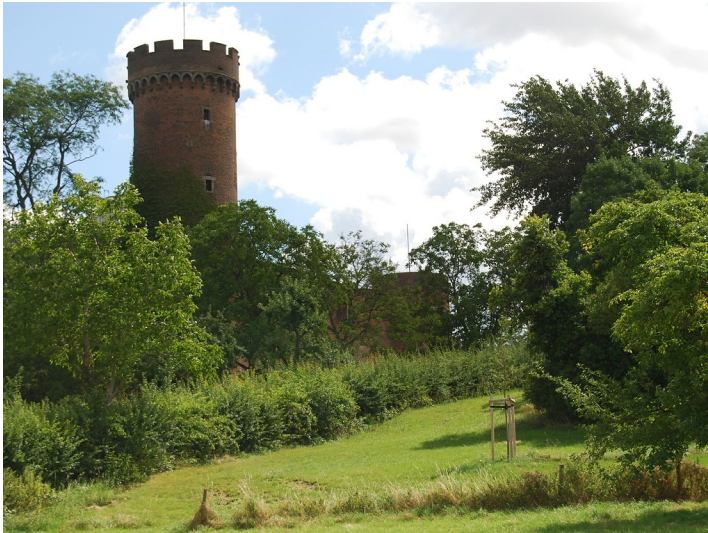
Landesburg Zülpich Fotograf/Urheber: LVR-Amt für Bodendenkmalpflege
