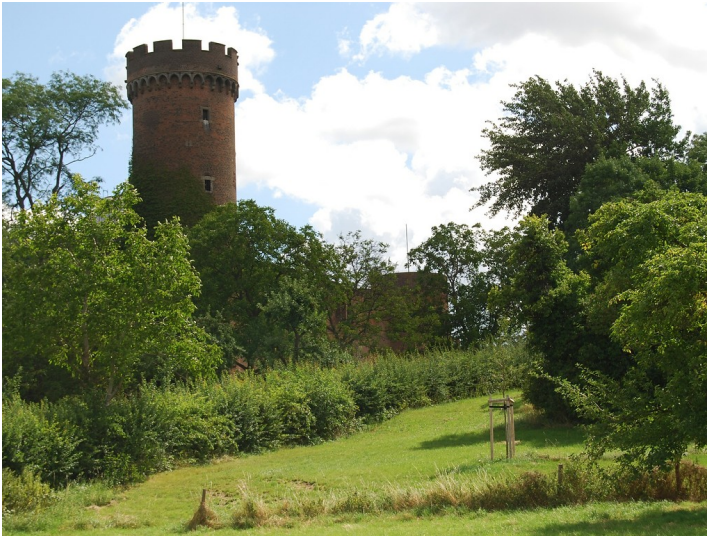
Landesburg Zülpich Fotograf/Urheber: LVR-Amt für Bodendenkmalpflege
