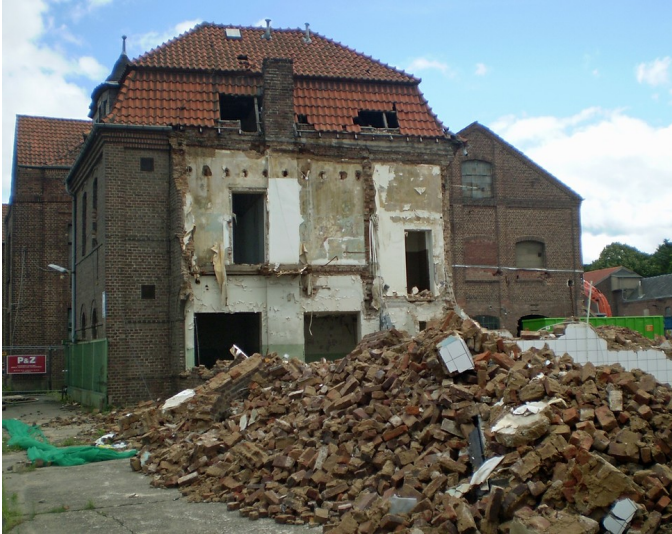
Kleutgen und Meier Bonn, abgerissener Gebäudeteil (2012)
