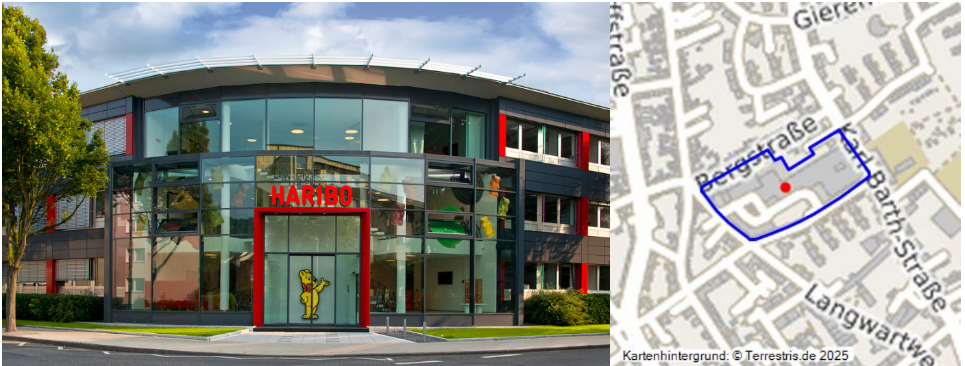
Zentrales Verwaltungsgebäude des Süßwarenherstellers Haribo GmbH & Co. KG am Standort Bonn, Hans-Riegel-Straße (2012) Fotograf/Urheber: unbekannt
