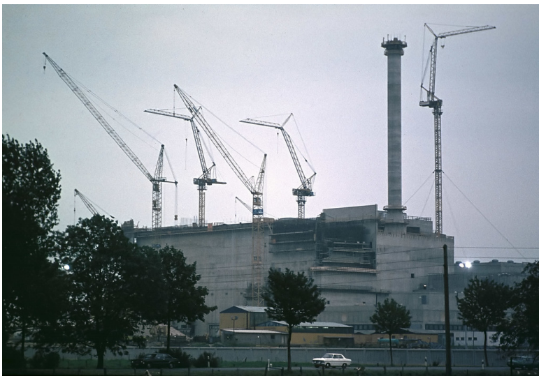
Die Baustelle des Kernkraftwerks "Schneller Brüter" in Kalkar im September 1977. Fotograf/Urheber: Smial
