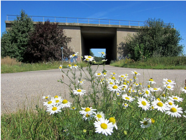
Die so genannte "Soda-Brücke", eine unvollendete Autobahnbrücke der Bundesautobahn A 56 bei Euskirchen (2012). Fotograf/Urheber: Franz-Josef Knöchel
