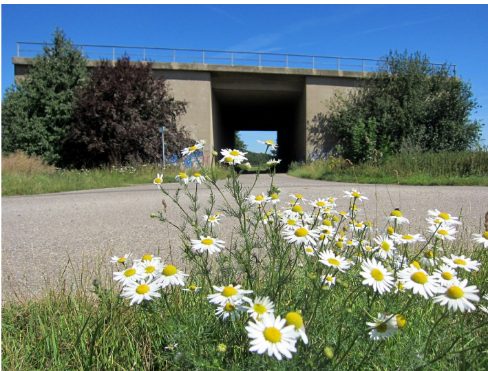
Die so genannte "Soda-Brücke", eine unvollendete Autobahnbrücke der Bundesautobahn A 56 bei Euskirchen (2012). Fotograf/Urheber: Franz-Josef Knöchel
