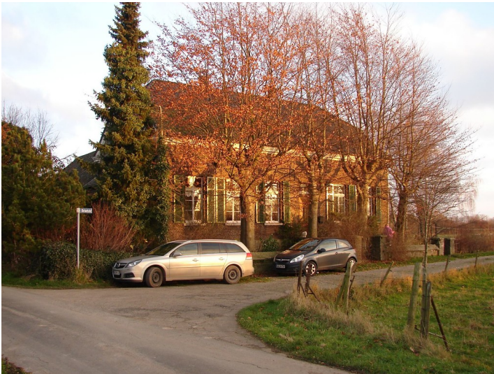
Wohnhaus Driwtstraße 1 in Kalkar Fotograf/Urheber: Marcin Radziszewski, Stadt Kalkar
