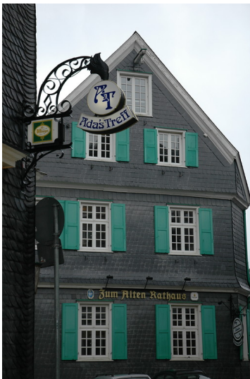
Schieferfassade in Lennep Fotograf/Urheber: Welp, Axel
